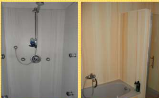
Sanierung Bad-WC - direkt über alte Fliesen
