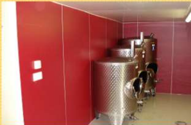
Umbau vom Stall zum Tankraum
