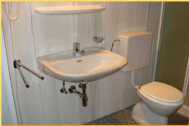
Sanierung Bad - WC - direkt über alte Fliesen
