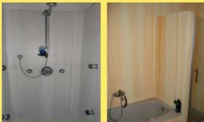
Sanierung Bad-WC - auch direkt über alte Fliesen
