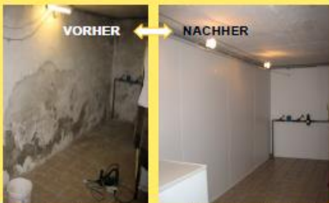
Kondensationsfeuchte wird saniert und vermieden durch
